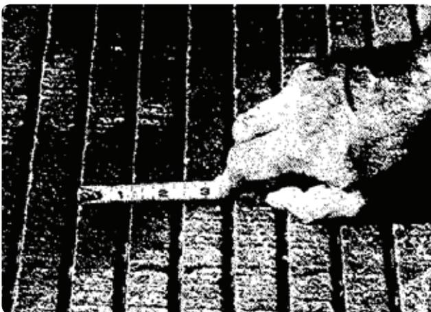
**Figura 13-161.** Superfícies de corte transversal da pista drenam a água rapidamente, mas aumentam o desgaste dos pneus.
